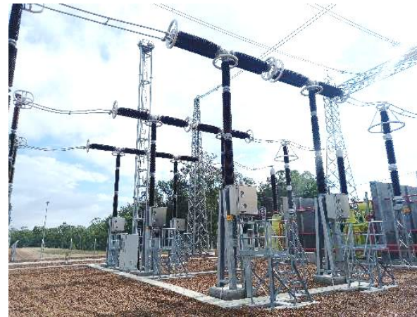
Reemplazo de Interruptores de Reactores
