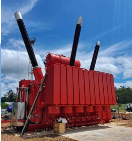
Nuevo Trafo Trifásico SGA 300 MVA
